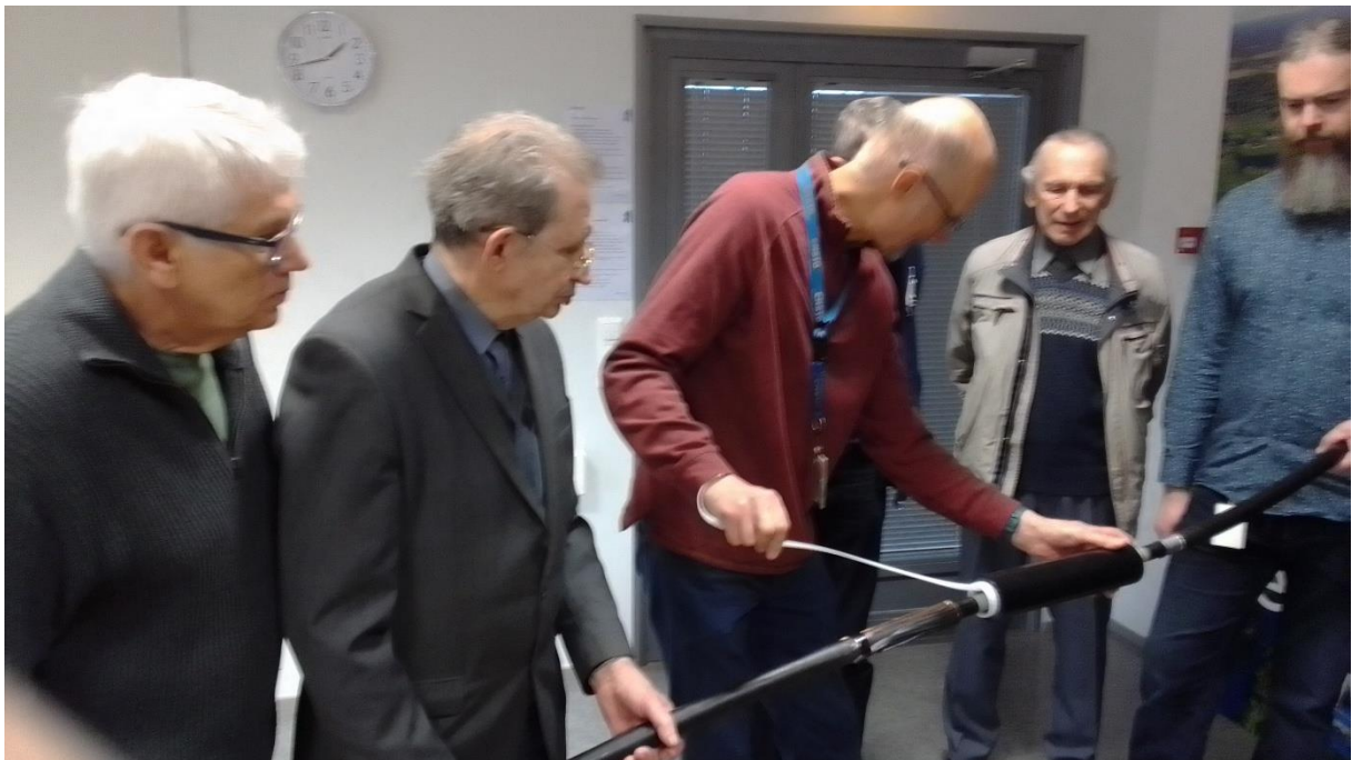
Jaanus Otsman paigaldamas uudset külmkahanevat kaablimuhvi.
